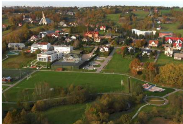
Po ukończeniu II etapu budowy Słoneczny Park w Sieprawiu jest magnesem dla lubiących aktywny wypoczynek. Fot. M. Sołtys
