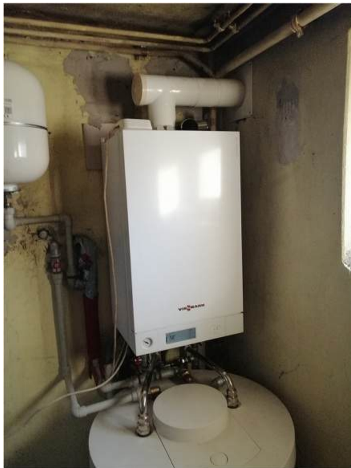
W ramach realizacji kilku programów wymieniano pieców zlikwidowano w ostatnich latach kilkaset nieefektywnych pieców węglowych, a zamontowano wysokosprawne piece np. gazowe. Fot. UG
