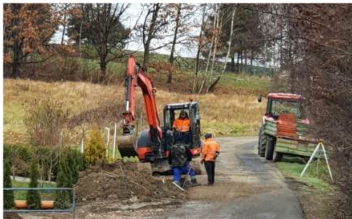
Budowa nowego odcinka kanalizacji. Fot. UG
