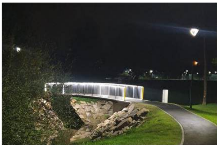
Kładka wybudowana w 2022 roku ułatwia dojście mieszkańcom do Słonecznego Parku i centrum Sieprawia od ul. Anieli Salawy. Fot. UG
