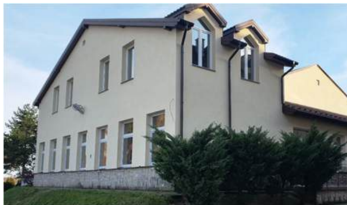
Po przebudowie budynku SP w Zakliczynie uczniowie mogą pobierać naukę w bezpiecznych i komfortowych warunkach. Fot. UG
