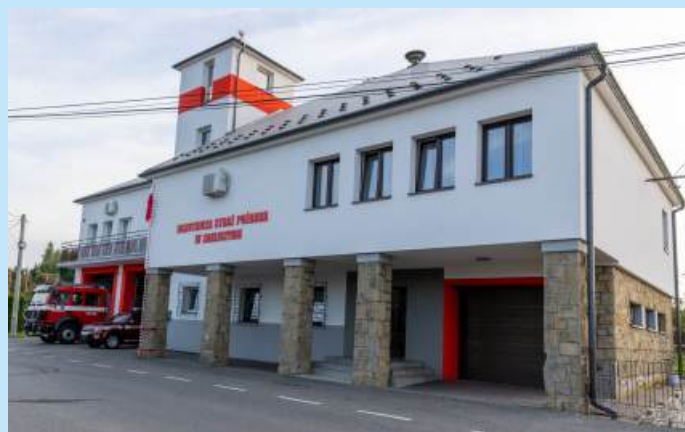
Termomodernizacja budynku remizy OSP w Zakliczynie str. 22
