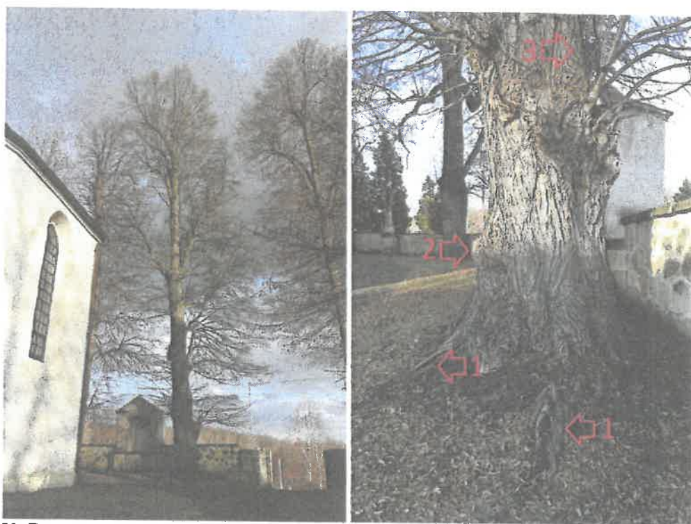
Fot. 49-50. Drzewo nr 16 – pokrój, uszkodzenia (1) w obrębie nabiegów korzeniowych, guzowate narośla (2), odrośla pniowe (3)
