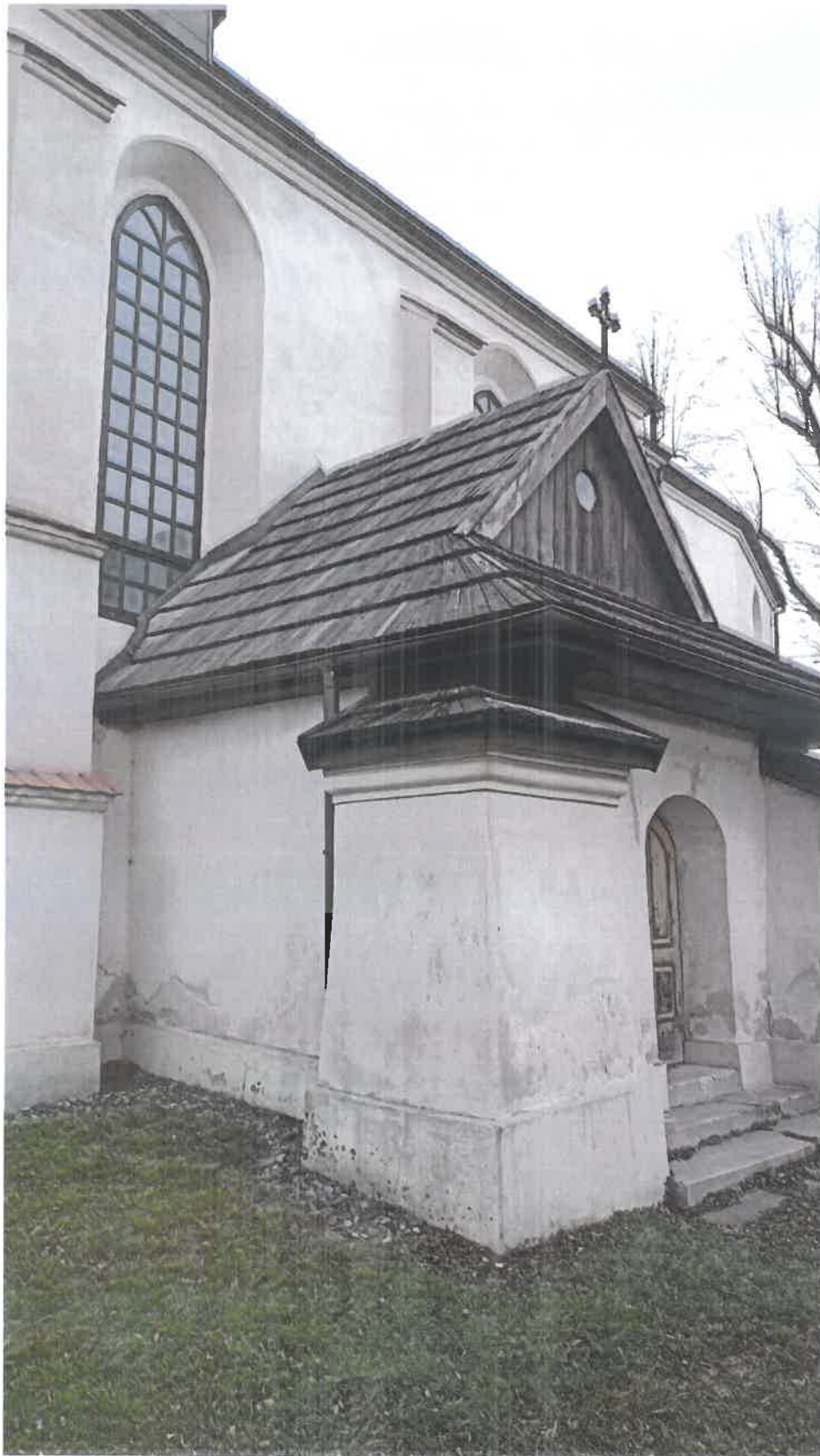
Fot. 6. Siepraw, ul. Jana Przytockiego Kościół p.w. św. Michała Archaniola . Widok od strony południowo zachodniej , babiniec.
