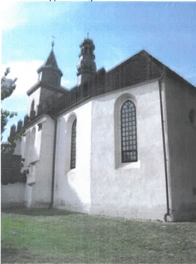
Fot. 2. Siepraw, ul. Jana Przytockiego Kościół p.w. św. Michała Archanioła . Widok od strony południowo wschodniej.
